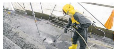
1a marcia - bassa potenza della pompa per il lavoro manuale con la pistola di sabbatura
